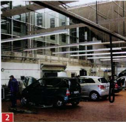
2 Rund 1.800 Fahrzeuge wird RKH dieses Jahr vermarkten 2 Die Pkw-Werkstatt mit 16 Arbeitsplätzen und ausschließlich Unterflurbühnen ist zum Lager hin voll verglast.
